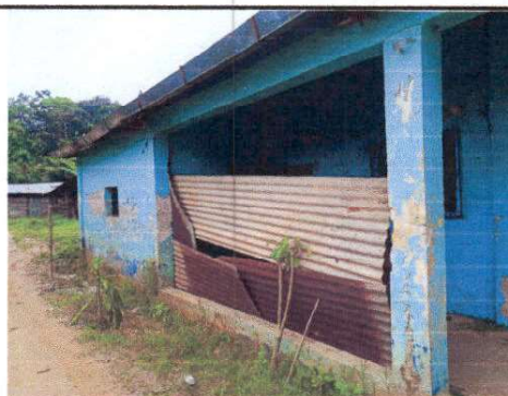
Foto 4: Sustitución de paredes de lamina por block de dirección
