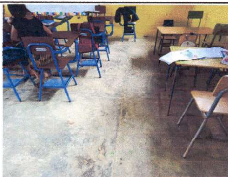
Foto 3: Sustitución de piso cerámico aula y dirección
