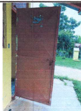
Foto 2: Mantenimiento de puerta
