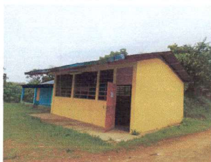
Foto 5. mantenimiento de lamina (cepillado y pintado)
