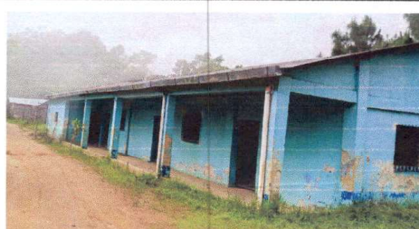
Foto 6: Repello en muro
